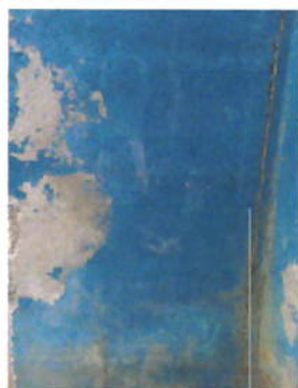
Foto 3: Preparación de la superficie y aplicación de pintura a dos manos, en paredes interiores y exteriores del establecimiento.
