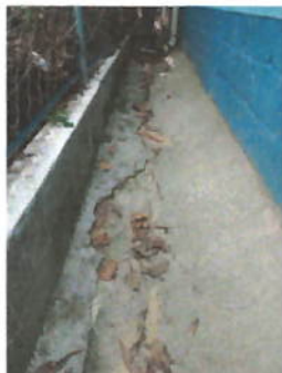
Foto 1: Reparación de canales de concreto para conducción superficial de agua pluvial, con pendiente y refuerzo.
