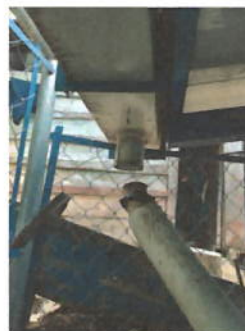
Foto 2: Sustitución de bajantes para evacuación de aguas pluviales anclada por medio de abrazaderas y tornillos.
