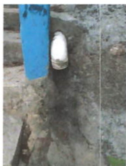
Foto 5: Sustrucción de tuberías PVC para redes hidráulicas de agua potable, adherencia entre cortes, uniones de tubería y accesorios con pegamento PVC.
