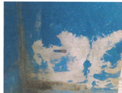
Foto 2: Reparación de repello y cernido en muro de mampostería con aplicación de acabado uniforme.
