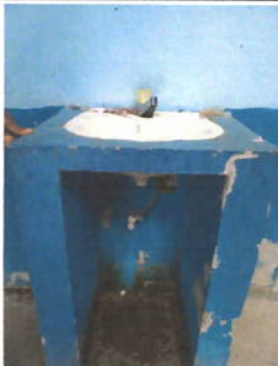
Foto1: Sustrucción de accesorios de servicios sanitarios y lavamanos.
