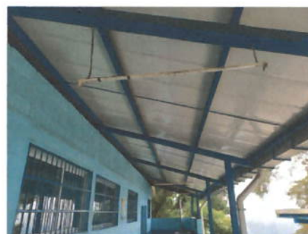
Foto 4: sustitución de sistemas de iluminación: Lámparas
